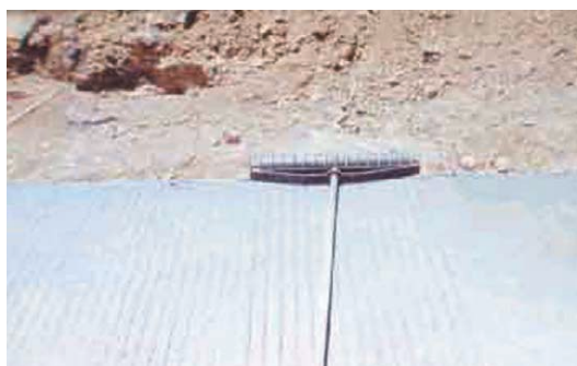
Figura 9 – Texturização manual com cilindro metálico dotado de anéis salientes.
