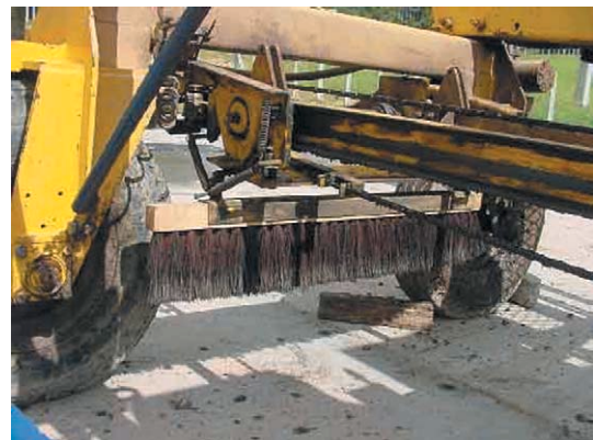
Figura 1 – Texturização mecânica com pente de fios flexíveis
