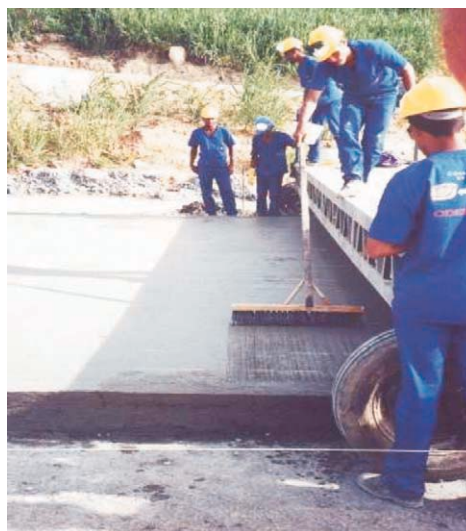
Figura 8 – Texturização manual com vassoura de fios duros.
