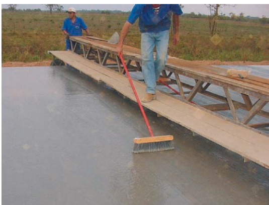
Figura 6 – Texturização manual com vassoura de piaçava.
