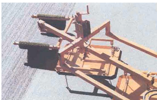
Figura 5 – Texturização mecânica longitudinal com carpete (faixa invertida de turfa ou grama artificial)
