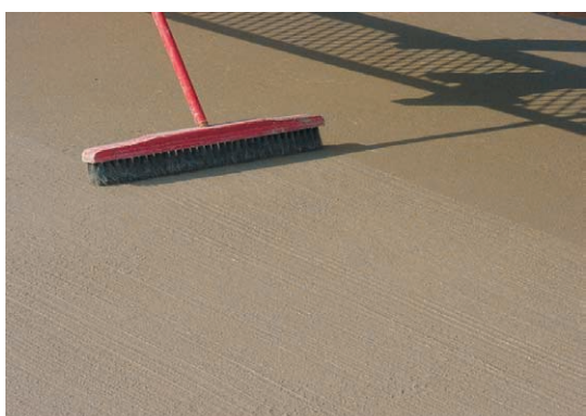
Figura 7 – Texturização manual com vassoura de piaçava.
