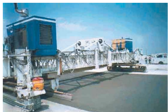
Figura 3 – Texturização mecânica com pente de fios flexíveis
